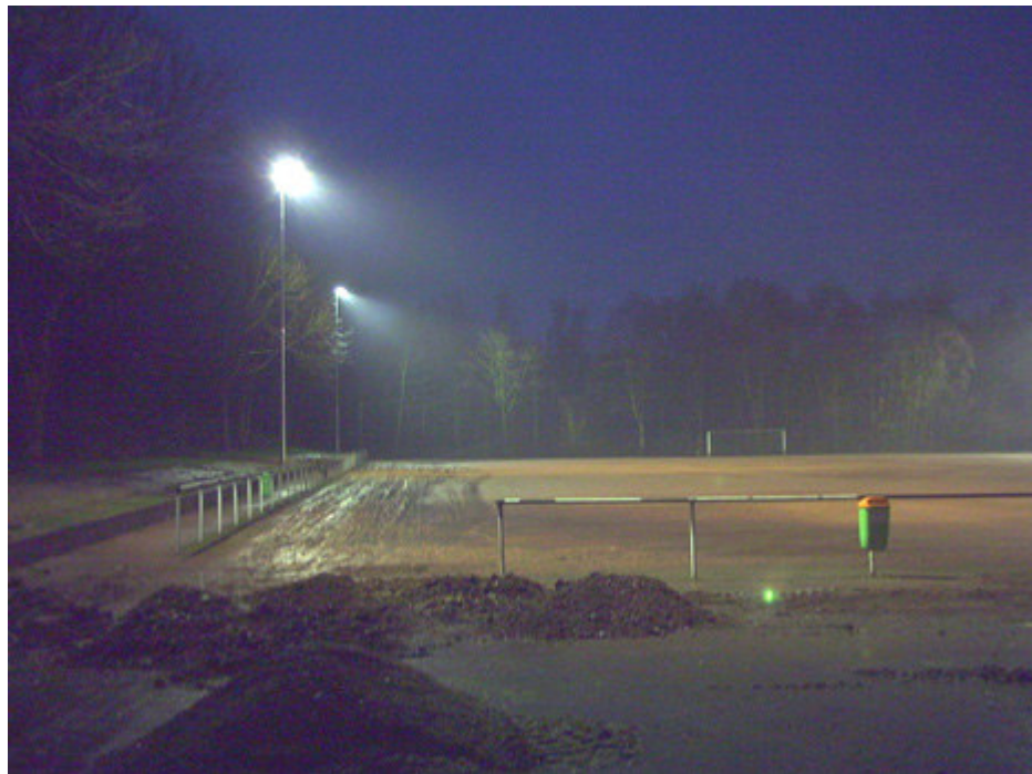
Die Lange Wanne in Recklinghausen erfüllt dank der neuen Beleuchtungsanlage die Anforderungen für den Trainings- und unterklassigen Spielbetrieb unter Flutlicht. Alle Bilder: IBR Flutlicht GmbH
