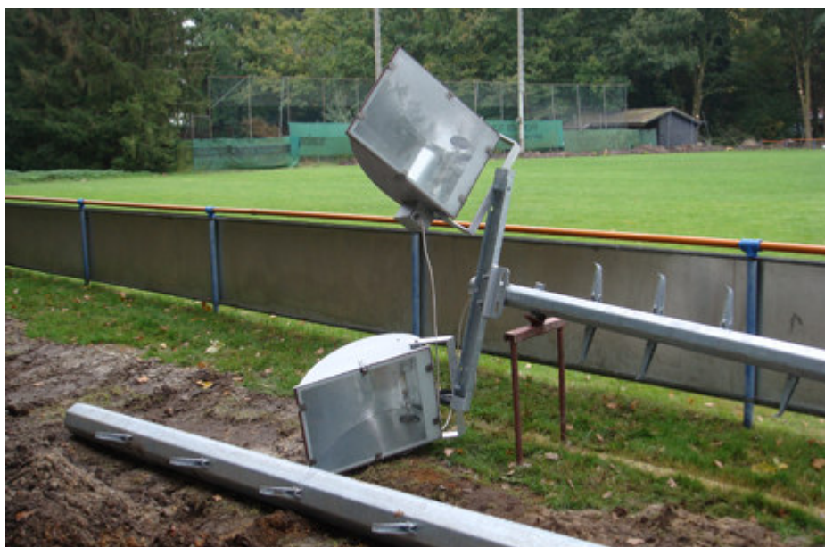
Die Verwendung gebrauchter Leuchten ermöglichte es der SG Schamerloh Kosten einzusparen.
