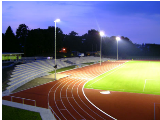
Dank der neuen Flutlichtanlage der IBR Flutlicht GmbH ist das Schlossparkstadion gut beleuchtet Bilder: IBR Flutlicht GmbH
