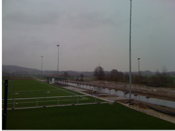
Zu Beginn der Saison 2010/2011 werden auch die Flutlichtmasten an neuen Naturrasenplatz stehen
