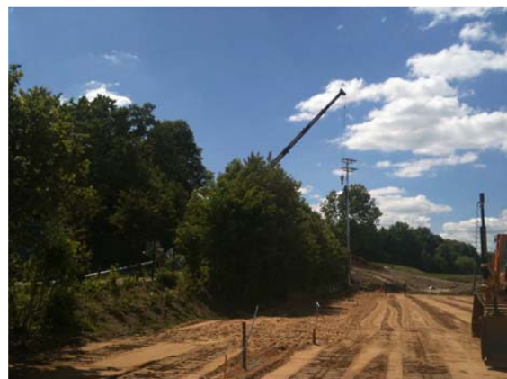
Ein Kran hebt den Mast über eine Böschung an seinen Standort
