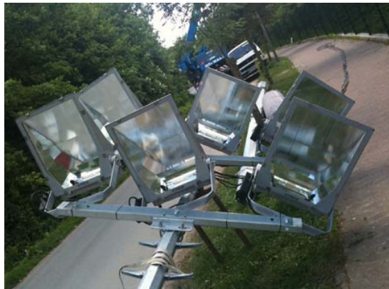
Endmontage in 18m-Höhe durch einen Facharbeiter der IBR Flutlicht GmbH
