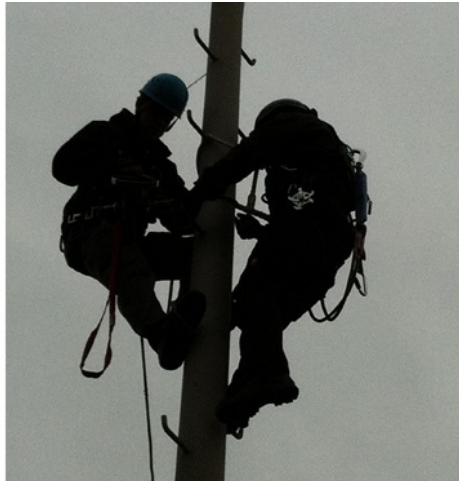
Für Wartungsarbeiten müssen Flutlichtmasten bestiegen werden Alle Bilder: IBR-Flutlicht GmbH - Ingenieurbüro Rößler
